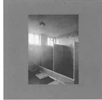
[36] Brausebäder für Steiger auf der Zeche der Niederrheinischen Bergwerks AG zu Neukirchen, aus dem Archiv Opländer
