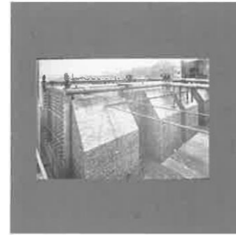
[65] 4 Batterien von Rauchgasvorwärmern zur Beheizung der Zechen, der Maschinenfabriken Deutschland und Both Et Fillmann, aus dem Archiv Opländer
