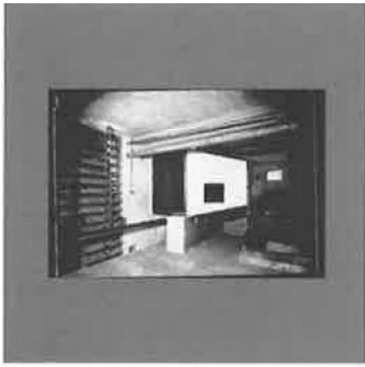
[62] Zuluftanlage für die Westfalahalle, aus dem Archiv Opländer
