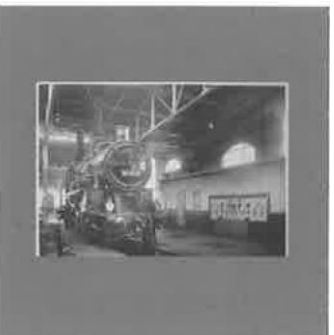
[67] Lokomotivwaschanlage, auf dem Bild ist rechts die Schalttafel zu sehen, aus dem Archiv Opländer
