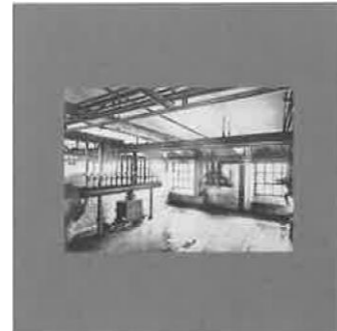
[40] Brausewassermischverteiler auf der Zeche Baldur Hervest in Dorsten, aus dem Archiv Opländer
