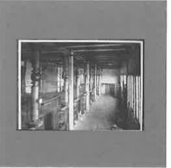
[57] Vielkesselanlage mit oberer Beschickung, aus dem Archiv Opländer
