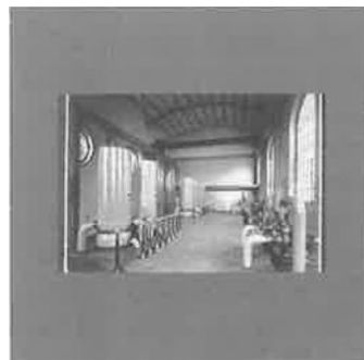
[38] Abwärmeverwertungszentrale auf der Zeche Auguste Victoria Hüls bei Recklinghausen, aus dem Archiv Opländer
