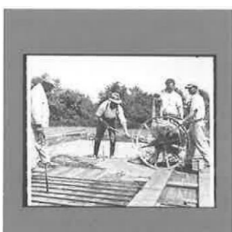
[103] Einbetonieren der Rohr-schlangen, aus dem Archiv Opländer
