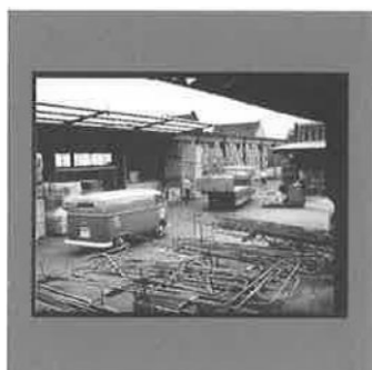
[99] vorgefertigte Elemente für Deckenstrahlungsheizungen auf dem Hof der Fa. Louis Opländer, aus dem Archiv Opländer
