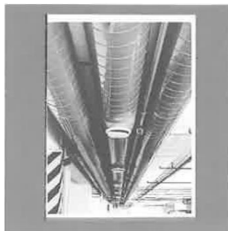
[111] ausgeführte Be- und Entlüftungsanlage einer Tiefgarage, aus Opländer Firmendruckchrift 7/75/BU
