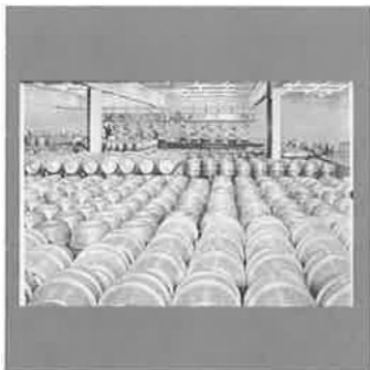
[118] Luft- und Klimaanlage für eine Faßabfüllhalle, aus Opländer Firmendruckchrift 7/75/BU
