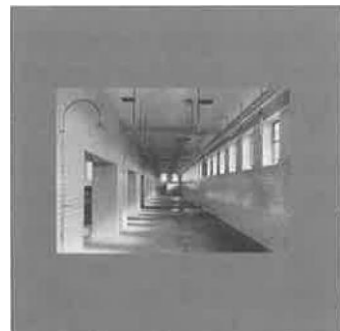
[37] Brauseraum für die Mannschaften auf der Zeche der Niederrheinischen Bergwerks AG zu Neunkirchen, aus dem Archiv Opländer
