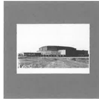
[60] Ansicht der ersten Westfalahalle 1925, aus dem Archiv Opländer
