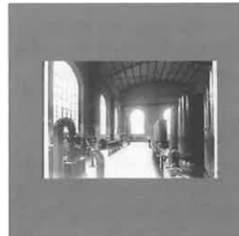
[39] Abwärmeverwertungs-Zentrale auf der Zeche Auguste Victoria Hüls bei Recklinghausen, aus dem Archiv Opländer
